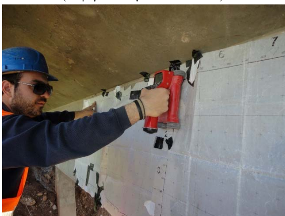
Φωτ. 5 Μαγνητικές ανιχνεύσεις χαλύβδινων οπλισμών (Άνω διάβαση νοσοκομείου Αιγίου).
