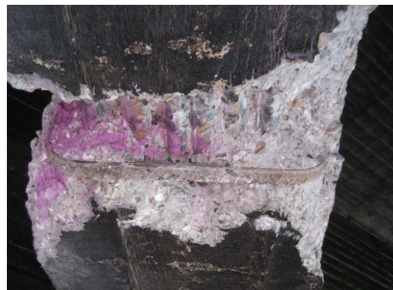
Φωτ. 4 Διερευνητική τομή και δοκιμή ενανθράκωσης (Γέφυρα ποταμού Σελινούντα).
