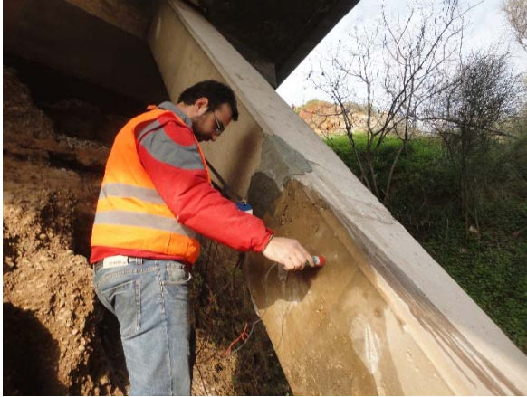
Φωτ. 7 Μέτρηση δυναμικού ημιστοιχείου χαλκού (Άνω διάβαση νοσοκομείου Αιγίου).
