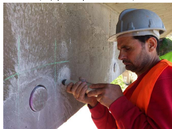
Φωτ. 6 Δοκιμή κρουσιμέτρου σε θέση λήψης πυρήνα για βαθμονόμηση των N.D.T. (Άνω διάβαση νοσοκομείου Αιγίου).
