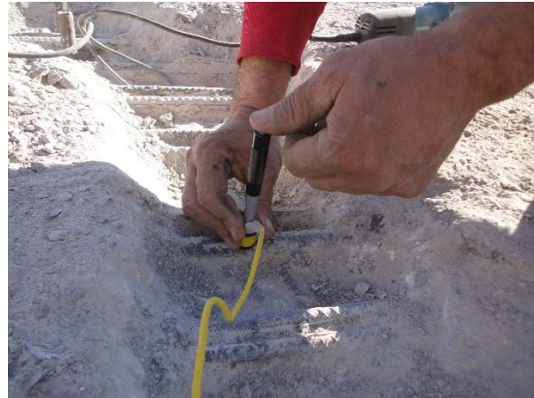
Φωτ. 10 Δοκιμή σκληρομέτρησης χαλαρού οπλισμού (Άνω διάβαση νοσοκομείου Αιγίου).
