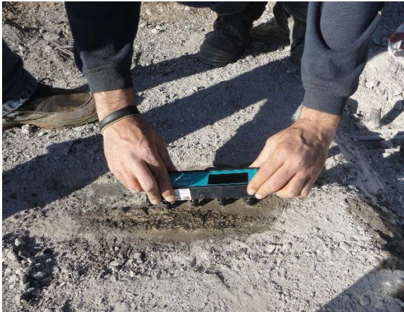
Φωτ. 9 Μέτρηση ηλεκτρικής αντίστασης σκυροδέματος (Άνω διάβαση νοσοκομείου Αιγίου).
