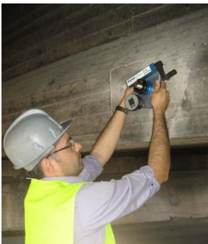
Φωτ. 3 Δοκιμή Pull – off (Γέφυρα ποταμού Σελινούντα).
