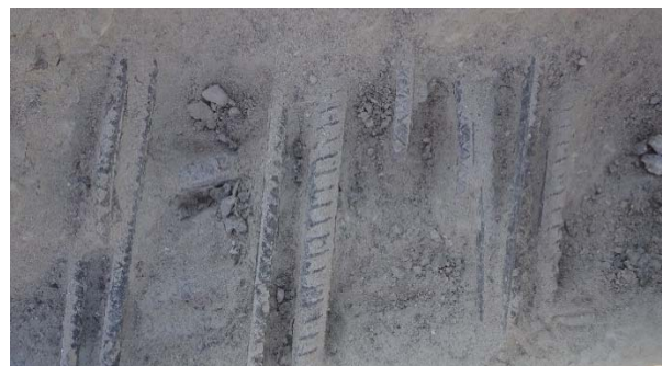
Φωτ. 12 Αποκάλυψη οπλισμών στην άνω παρειά του καταστρώματος (Άνω διάβαση νοσοκομείου Αιγίου).
