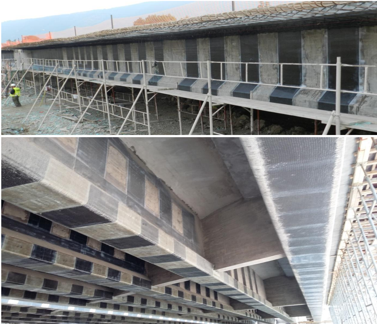
Σχ. 7 – Εφαρμογή ινοπλισμένων πολυμερών FRP για την καμπτική και διατμητική ενίσχυση του φορέα
