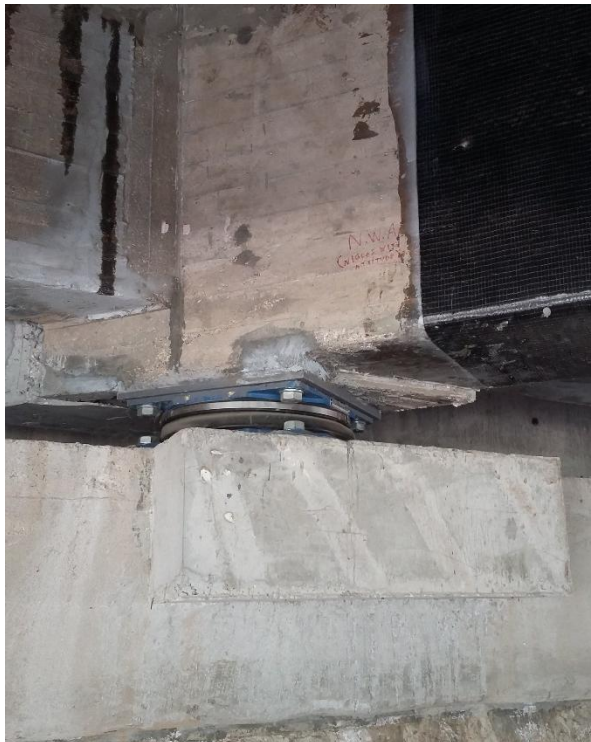
Σχ. 8 – Εφεδρανο σεισμικής μόνωσης τύπου τριπλού εκκρεμούς τριβής (triple FPS).
