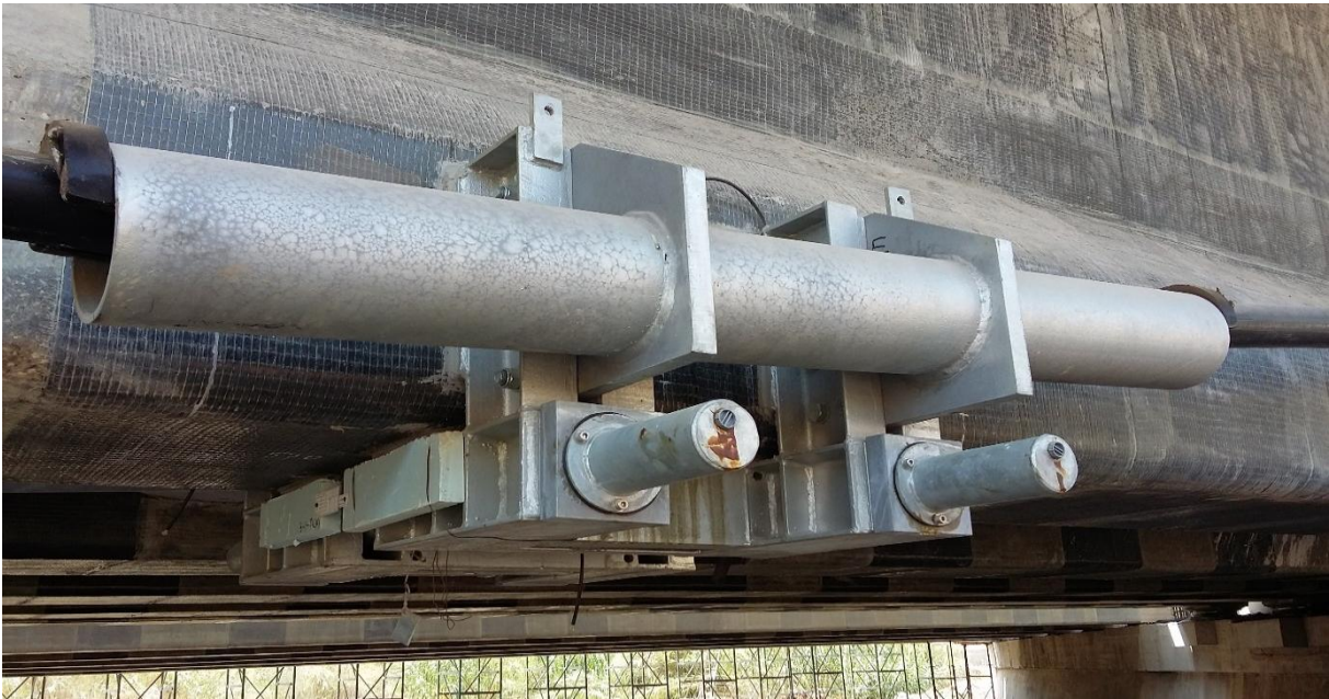
Σχ. 4 – Όψη του στοιχείου εκτροπής της εξωτερικής προέντασης στα L/4 και 3L/4 της δοκού. Η ευστάθεια του εξασφαλίζεται από δύο εγκάρσια προεντεταμένες ράβδους \Phi 26.5 ποιότητας Y1030.
